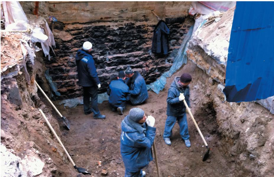
*Работы по замене металлоконструкций над сводом Большого зала и укрепление фундаментов театрального здания*
