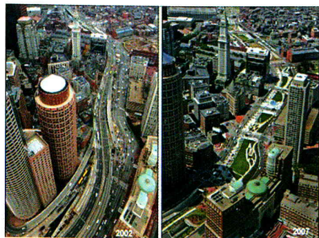
Спрятанная под землю магистраль в Бостоне
