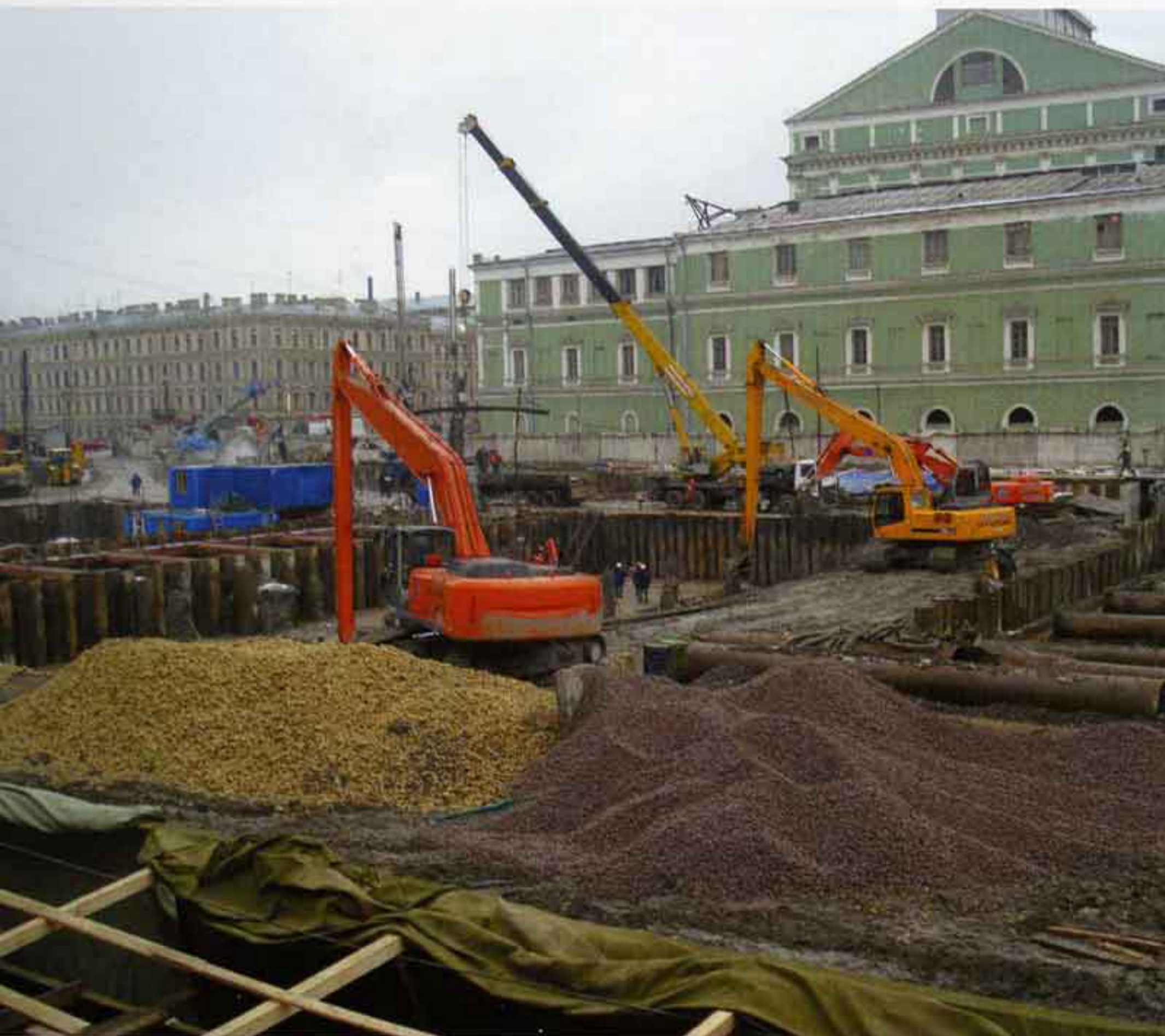
Работы по сооружению подземного объема ГАМТ-2. Январь 2009 г.
