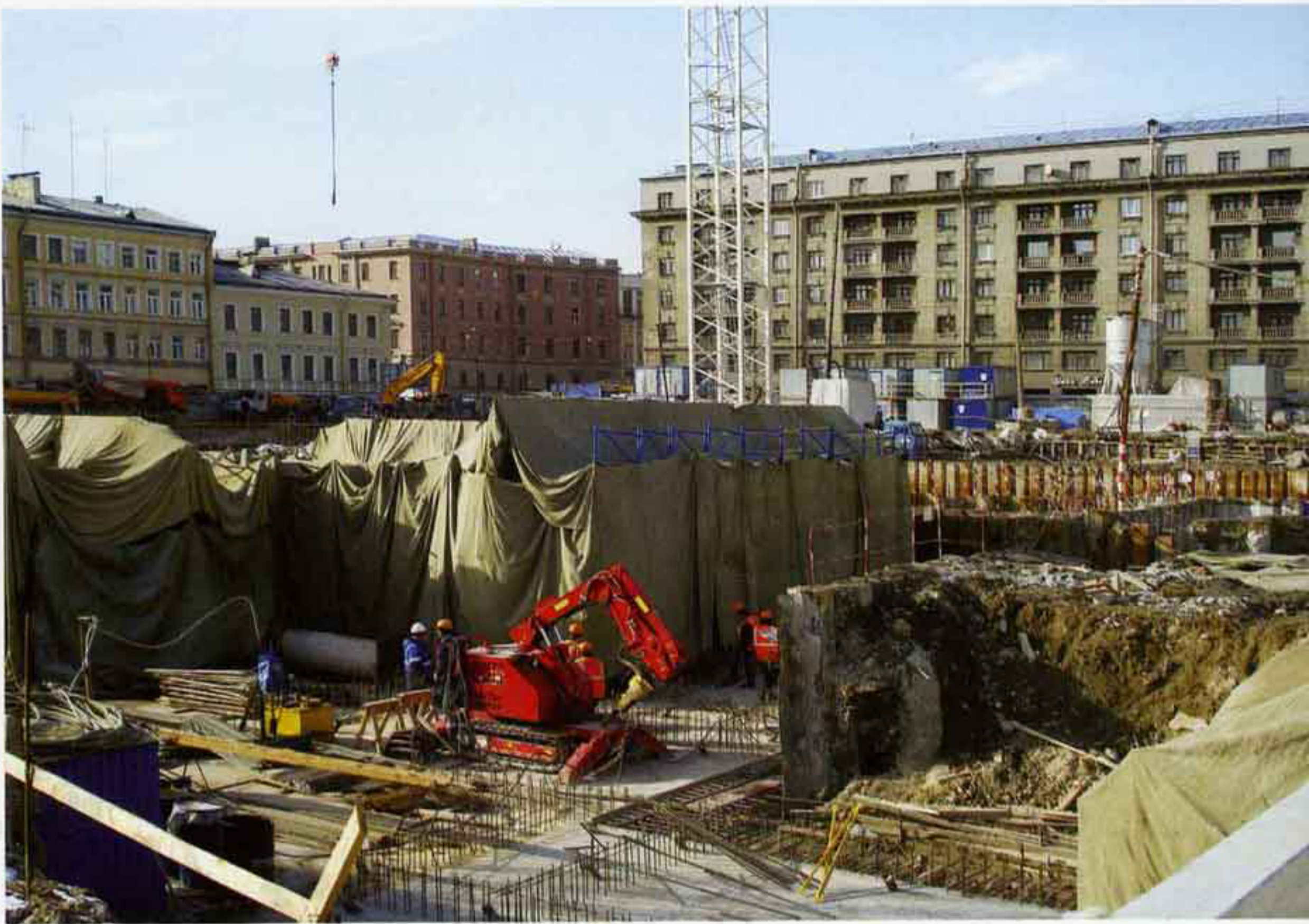
Работы по сооружению подземного объема ГАМТ-2. Март 2009 г.
