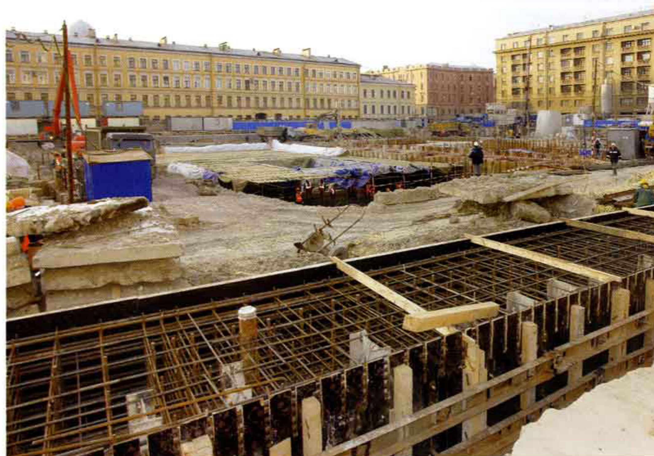
Строительство нового театра идет полным ходом
