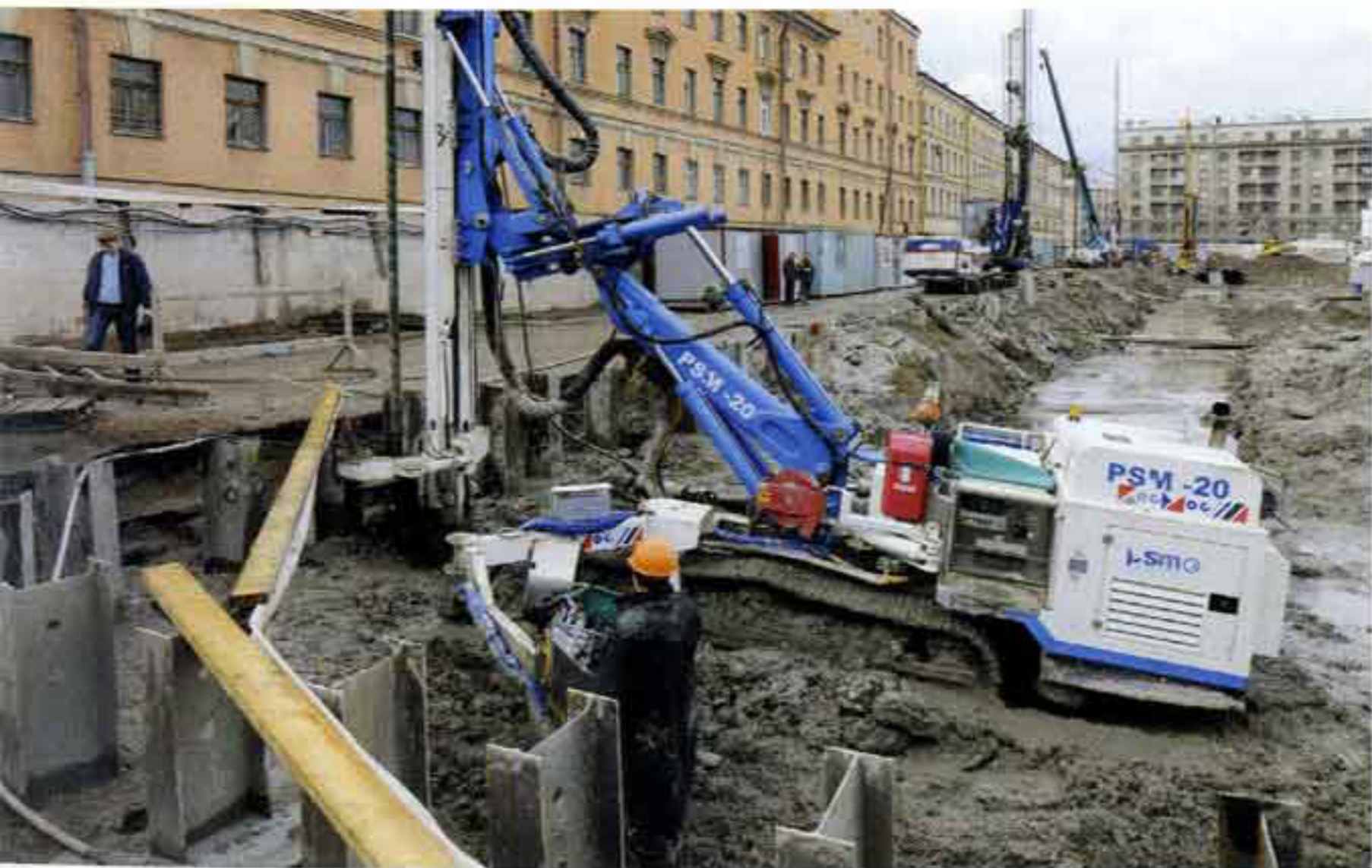
Работы по сооружению подземного объема здания ГАМТ-2. Январь 2009 г.
