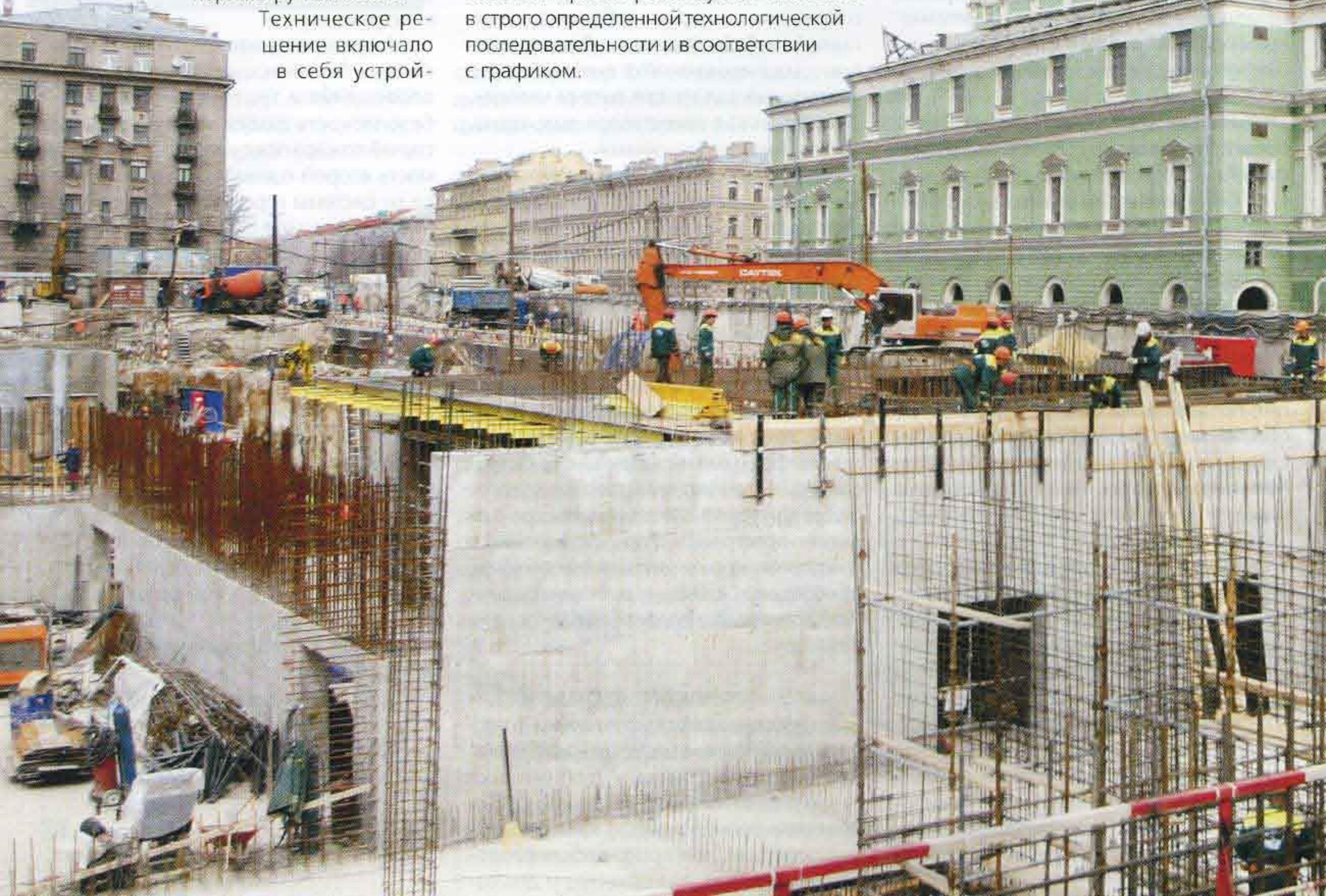
В то же время во второй зоне ведутся работы пока только на отметке минус 4 метра. Там происходит обвязка арматуры и бетонируется плита постоянной конструкции. Одновременно работать по всему периметру котлована на одной отметке небезопасно, так как, даже несмотря на дополнительное усиление, необходимо полностью исключить возможность подвижек грунта.
