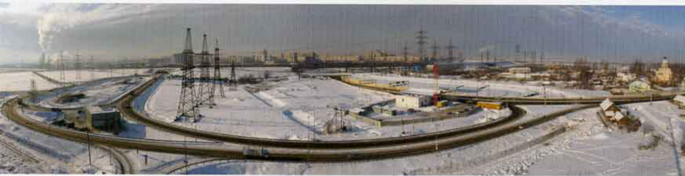
Муринские тоннель и развязка «Космоса СПб» на Кольцевой автомагистрали
